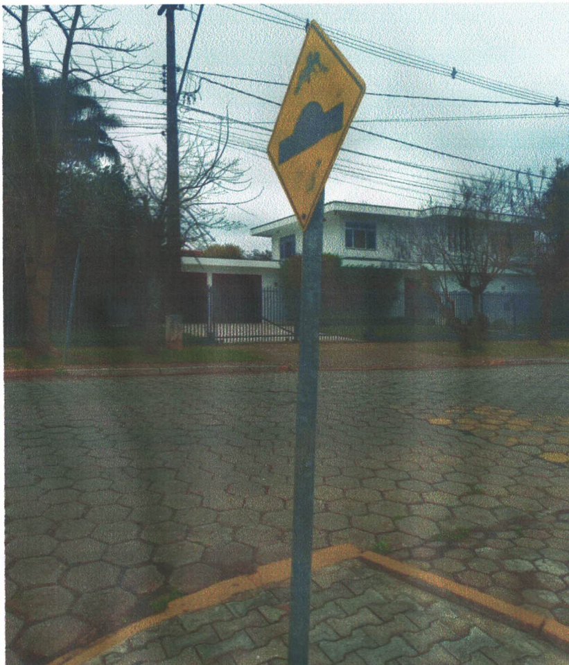
Figura – Realizar a manutenção da lombada
